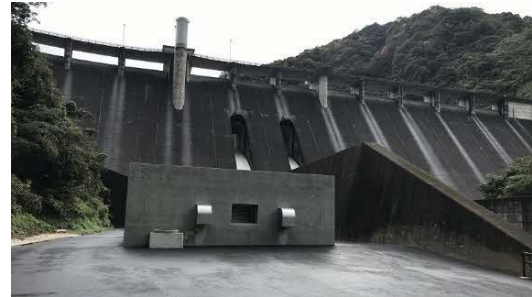
大長見発電所
