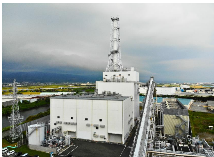
鈴川エネルギーセンター発電所外観
